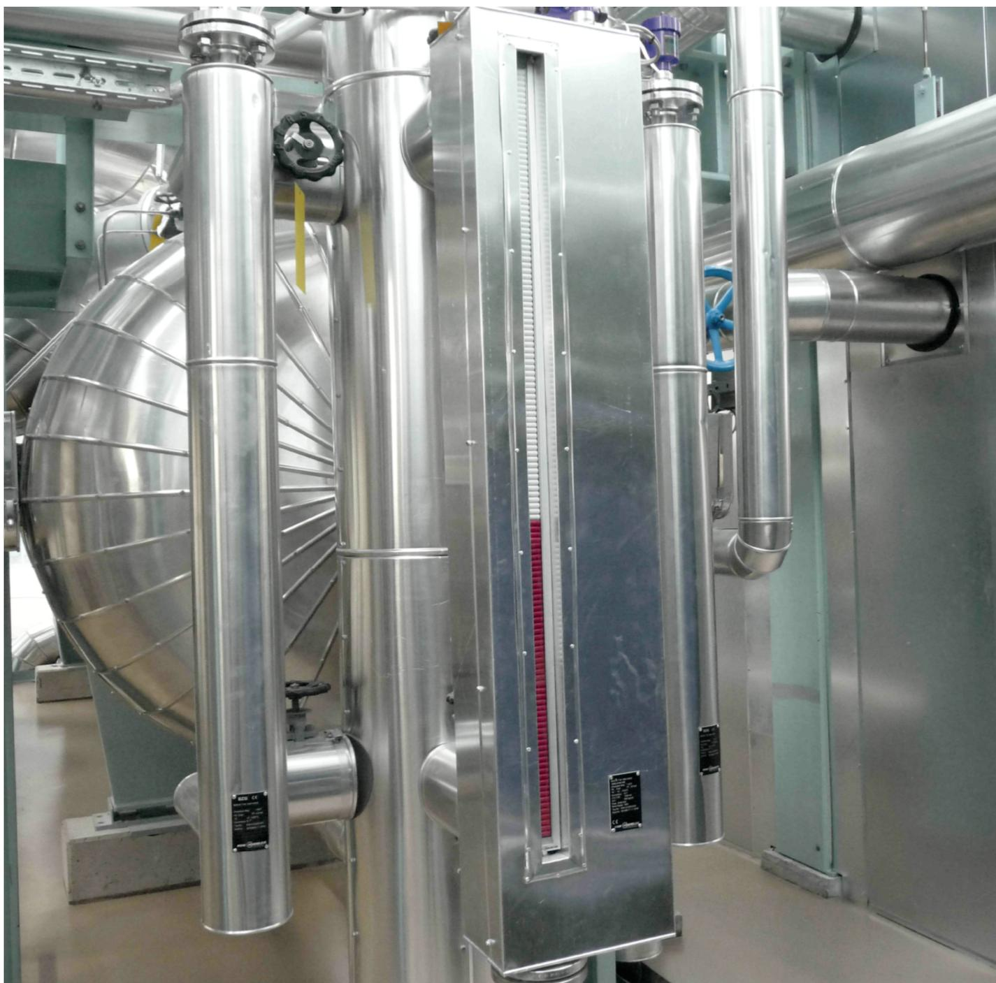
В сообщающейся байпасной камере, установленной сбоку на резервуаре, есть поплавок, который перемещается одновременно с уровнем измеряемой среды. Магнитное поле, создаваемое радиально-симметричной магнитной системой поплавка на глубине погружения, активирует магнитный роликовый индикатор, установленный снаружи байпасной камеры, а также переключающие и измерительные элементы.
